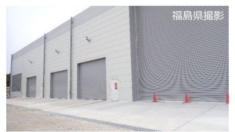
減容処理設備の外観
