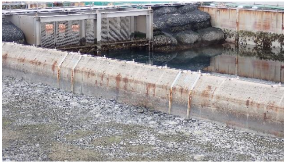
(写真5) 1-4号機取水路開渠出口魚類移動 防止網の状況(東波除堤北側から南 西方向を撮影)
