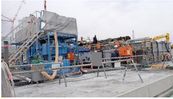
(写真3) 被覆材調製プラントでの作業状況 (南東側から撮影)
