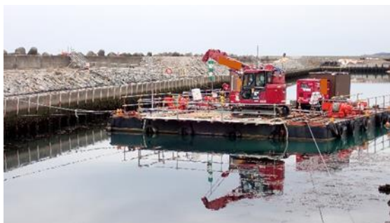
(写真2) ユニフロート台船の概観 (北西側から撮影)
