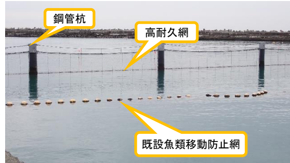
(写真4-2) 本設東波除堤魚類移動防止網の設置 状況②(同左)
