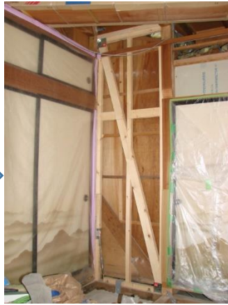
耐震改修の状況
