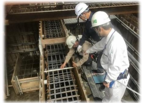
工事監理 (配筋検査)
