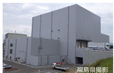
増設雑固体廃棄物焼却設備
