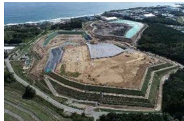
中間貯蔵施設の様子
