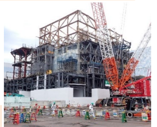
1号機の大型カバー設置の様子
