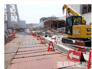
フェーシング前 (3号機付近)
