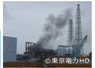
水素爆発を起こした直後の3号機
