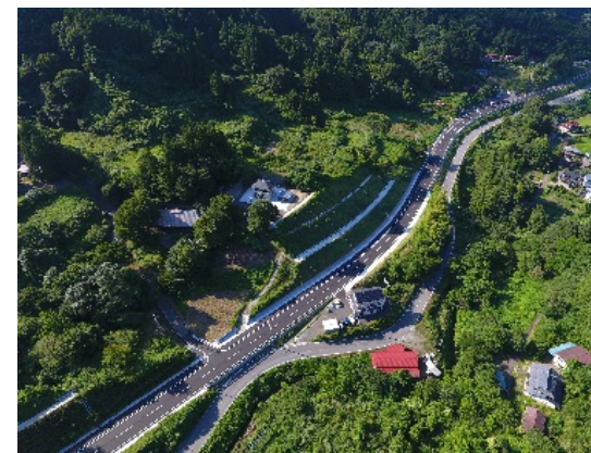
国道349号 (川俣町大綱木工区) 2023年3月21日 供用
