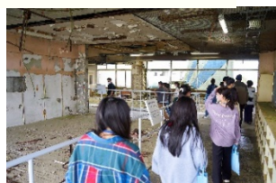
震災遺構浪江町立請戸小学校
