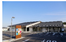
大熊町：商業施設
