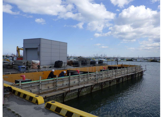
岸壁（I-3） 復旧中
