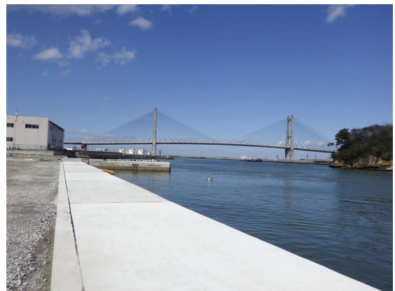
護岸（H-2） 復旧後
