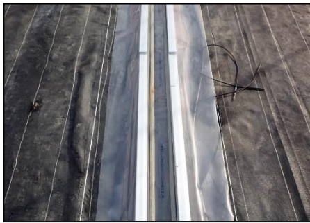
③直管パイプ等を角材の内側に置いて 固定します。
