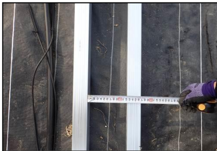
① ロックウールマットが乗る幅 に角材を配置していきます。
