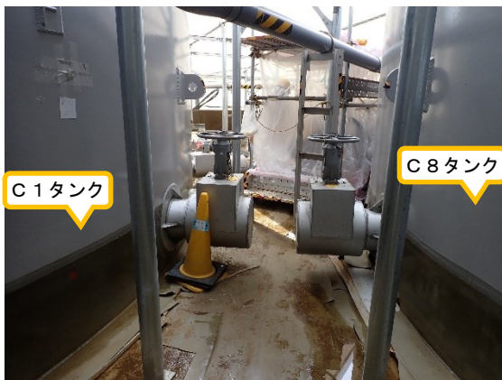
(写真3-2) タンク連結管の状況② (メーカー推奨変位値を超過した 連結管の撤去状況) (C1-C8タンク間)
