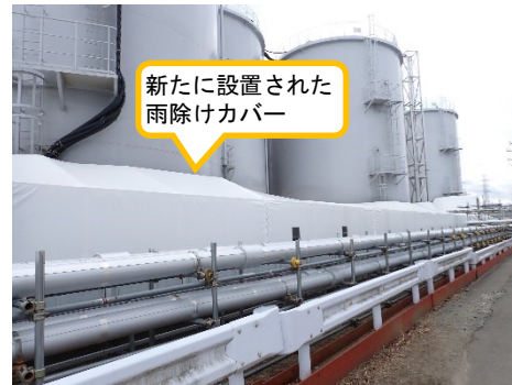
(写真4-2) 新たな雨除けカバーの設置状況 Dタンクエリア北側 (撮影：令和6年3月21日)
