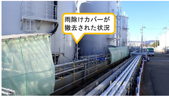
(写真4-1) 雨除けカバーの撤去状況 Dタンクエリア北側 (撮影：令和5年12月25日)
