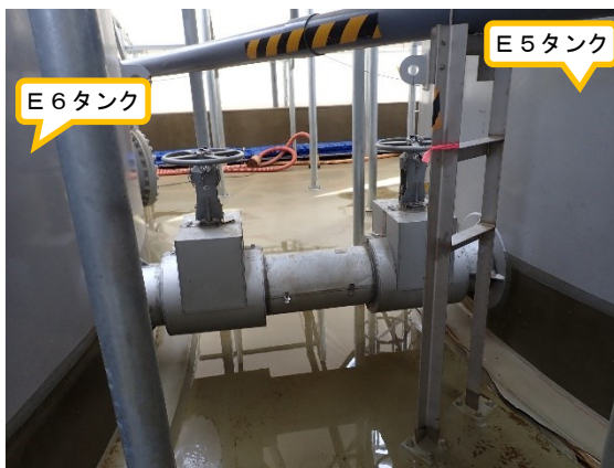
(写真3-1) タンク連結管の状況① (E5-E6タンク間)
