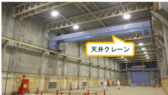
(写真3-1) 定検機材倉庫B棟の内部
