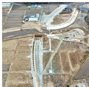
県道小野富岡線の整備状況
