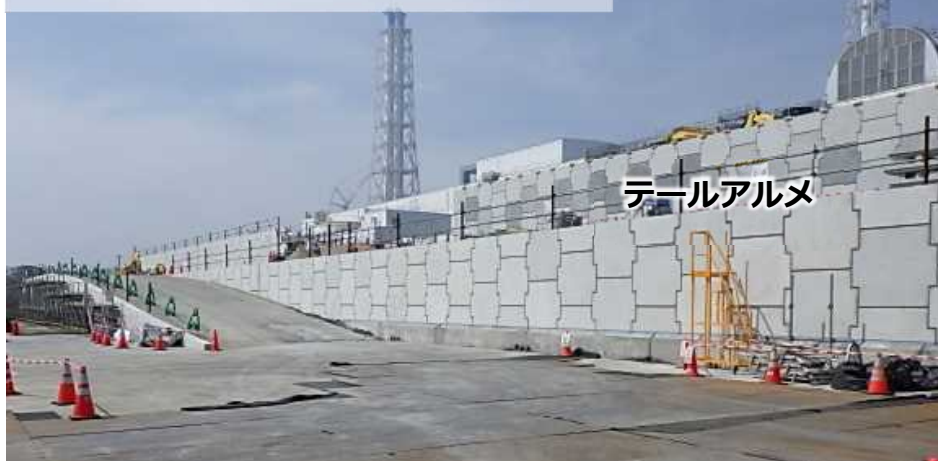
テールアルメ設置状況
