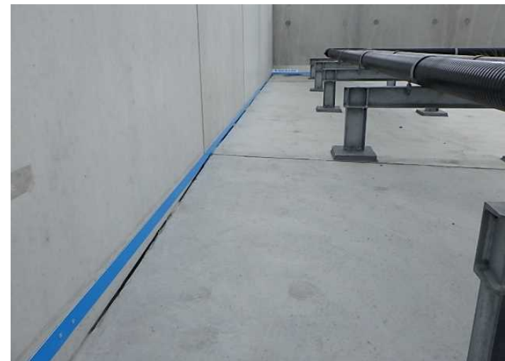
写真②：防潮堤設置状況 (2023年8月21日撮影)
