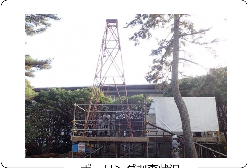
ボーリング調査状況
