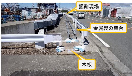
(写真2) 掘削現場の東側の状況 (東側から撮影)
