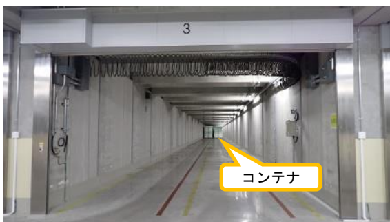
(写真 2 - 3) 貯蔵庫棟内の状況③ (地下 1 階の貯蔵レーンでの保管状況の例) ※同様の貯蔵レーンが 7 レーンある
