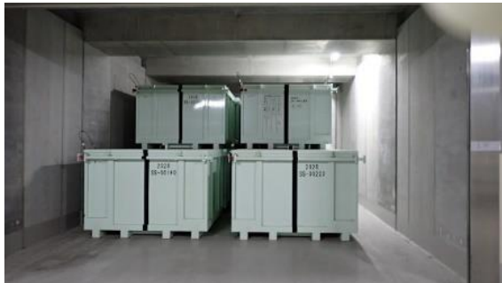
(写真 2 - 1) 貯蔵庫棟内の状況① (地上 1 階の貯蔵レーンでの保管状況の例) ※同様の貯蔵レーンが 7 レーンある
