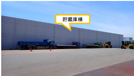
(写真 1 - 2) 固体廃棄物貯蔵庫第 9 棟の外観②
