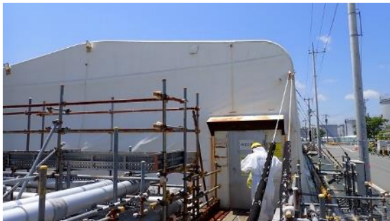
(写真1-1) 淡水化装置RO3建屋外観
