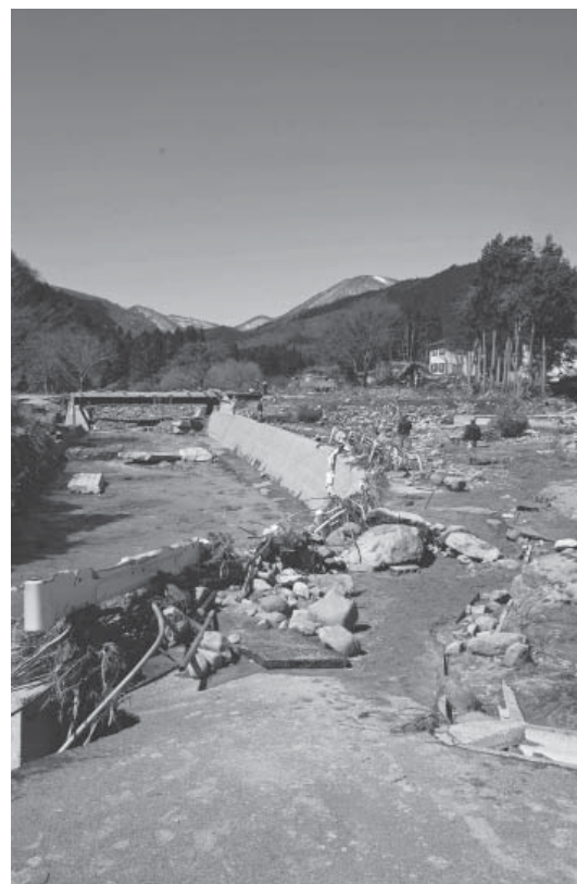
(橋りょうなどの被災状況 長沼地内)
