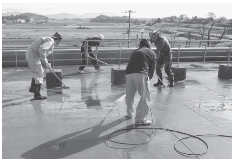
(市内中学校 除染作業)
