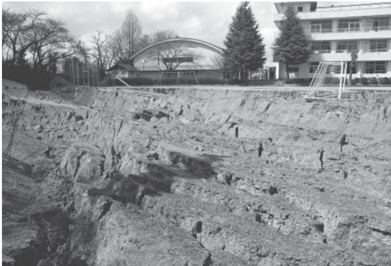
(被災状況 第一小学校グラウンド)
