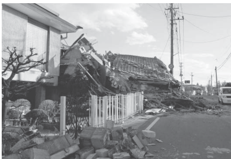
(家屋の被災状況 南町地内)
