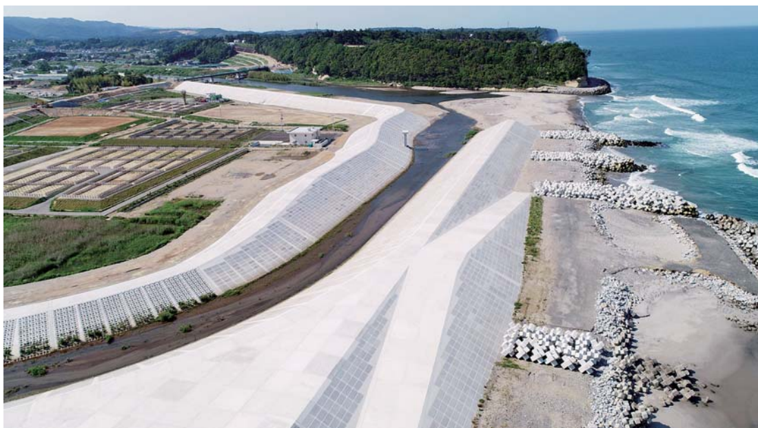
新たに整備された堤防(8.7m)
