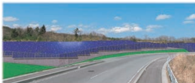
図：シャープ富岡太陽光発電所(富岡工業団地内)のイメージ 平成27年6月稼働(予定)
