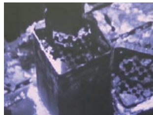
燃料の溶け落ちた炉で初めて、遠隔操作による使用済燃料プールからの燃料取り出しを開始(3号機)。【2019.4】
