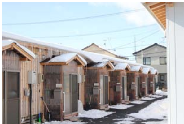
会津若松市内にある仮設住宅
