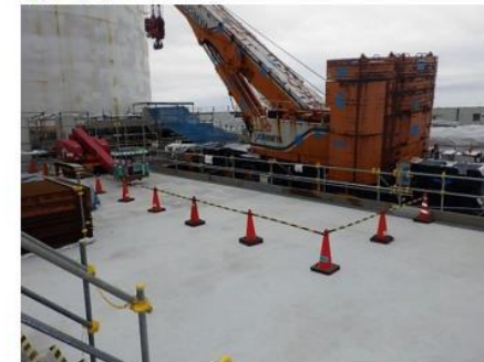
建屋周辺の舗装
