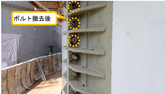
(写真2②) フランジ接続部分のボルト撤去状況
