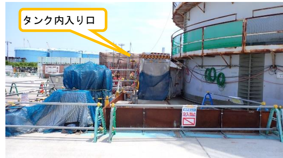
(写真3) タンク内入口の状況
