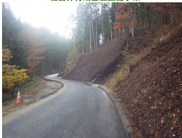
林業専用道「小塩麻布支線」(南会津町)
