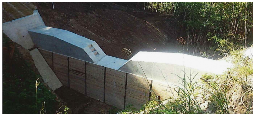
治山事業による荒廃溪流の復旧(南会津町獅子落山地区)
