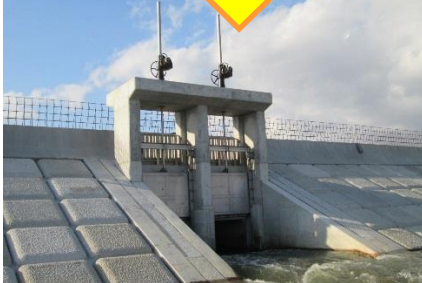
中浜田樋門 (新地町)
