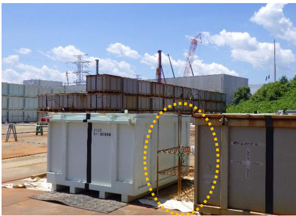
(写真3-1) 詰替え作業カイゼンで設けられた新旧保管容器間の補助台
