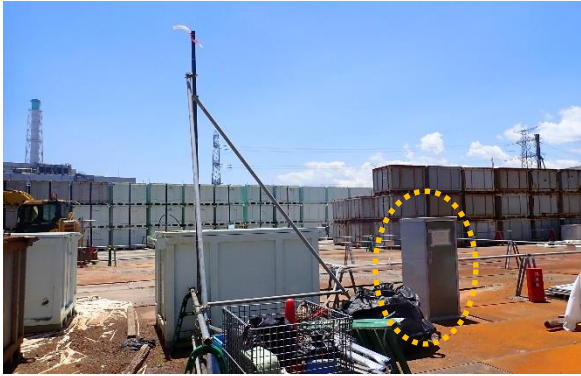
(写真2) 一時保管エリアCC概観と詰替え作業エリア内で使用しているダストモニタの取付け状況 (北側から撮影)
