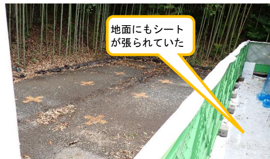
(写真2②) 囲い内部
