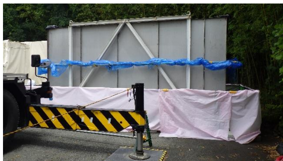
(写真2①) 保管容器周辺の養生
