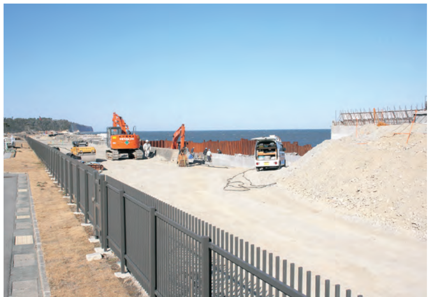
防潮堤（高さ 8.7m）の整備状況
