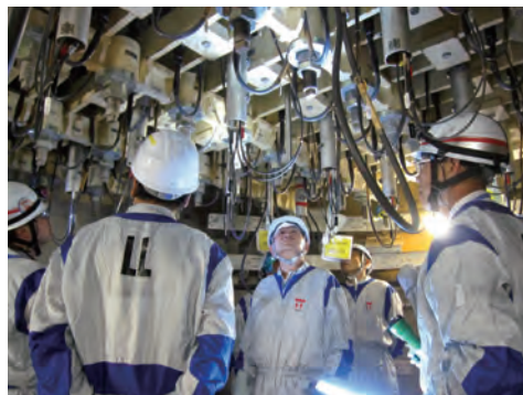
原子力施設監視委員会による福島第二原子力発電所の視察
