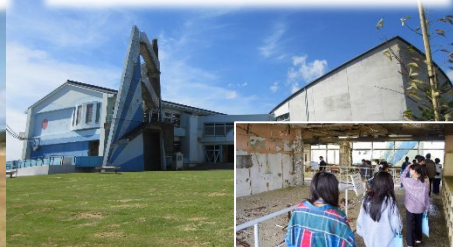
震災遺構浪江町立請戸小学校
