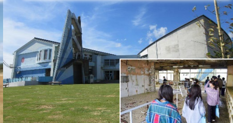
震災遺構浪江町立請戸小学校
