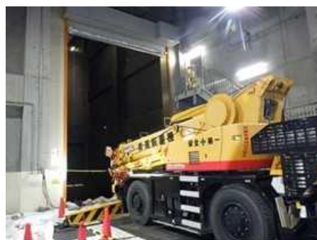
ラフタークレーン配置
