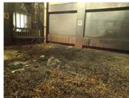
3/7撮影 廃棄物貯留ピット内の状況
