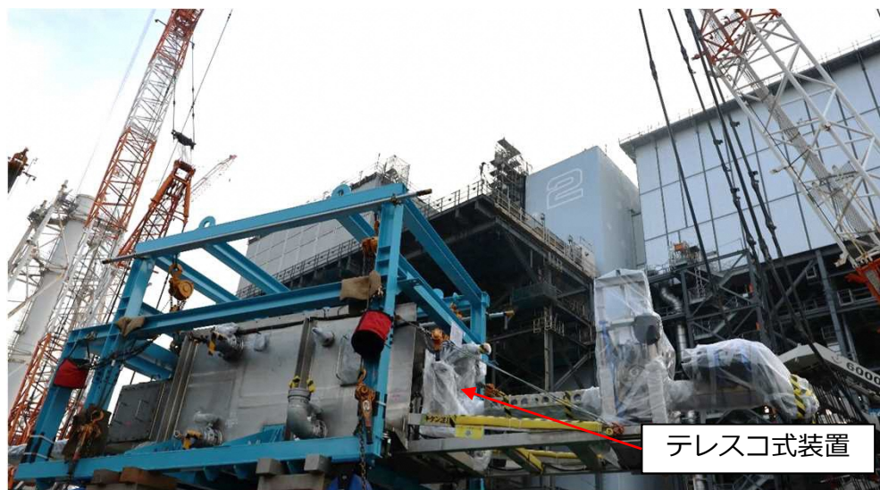
7/19 原子炉建屋内への搬入状況
