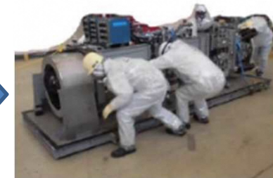
堆積物除去装置 (低圧水) 撤去
