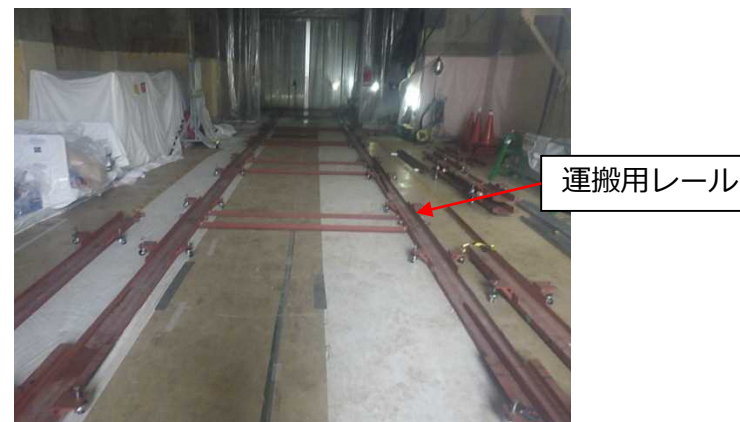
7/18 運搬用レール敷設後
