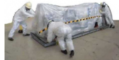
堆積物除去装置 (高圧水、AWJ) 撤去
