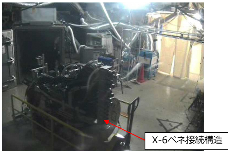
X-6ペネ接続構造をR/B北西エリアに運搬
