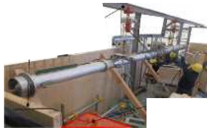
スプレイ治具設置 ※X-53ペネに接続
