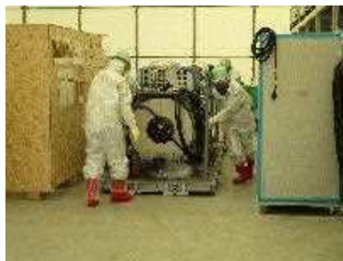
堆積物除去装置 (高圧水、AWJ) 設置
