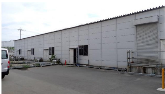
(写真1-1) 多核種移送設備建屋の外観
