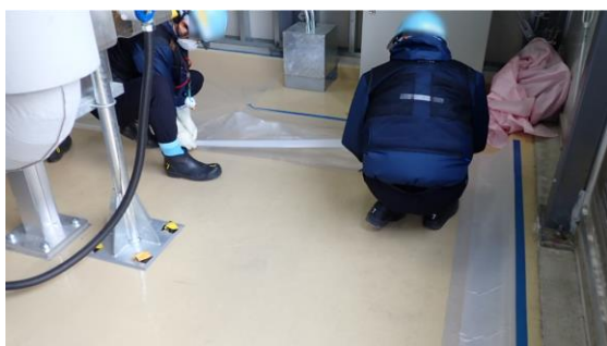
(写真2) クリーンエリア設置作業の様子
