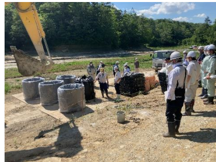
モデル事業の研修会（大型土のう製作状況）
