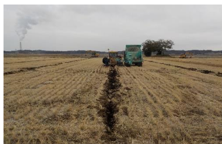
真野地区における暗渠排水工事状況 (南相馬市鹿島区)
