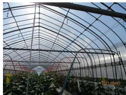
簡易ミスト設置状況
