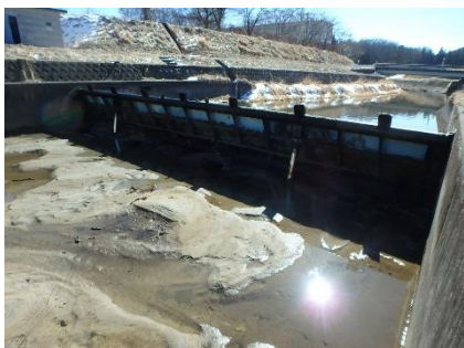
転倒ゲート塗装修繕（施工前） 大関頭首工（田村市）
