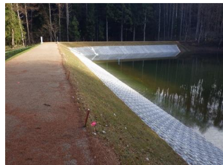
同地区 防災工事施工後
