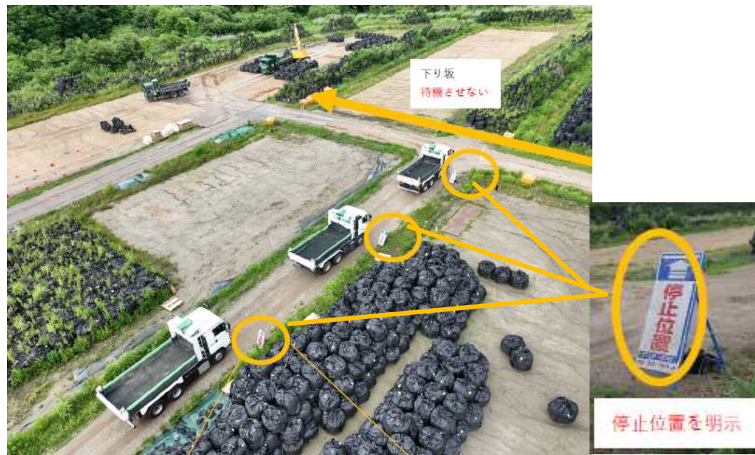
【現場の対策状況】
