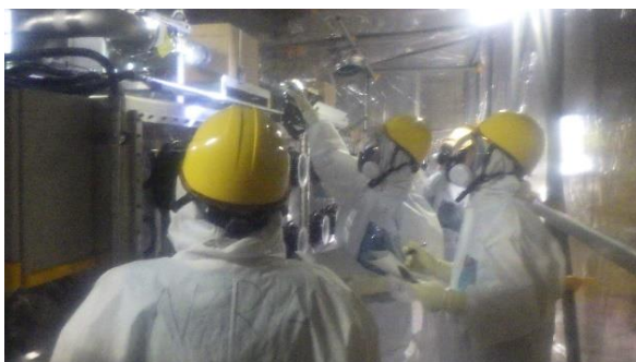
(写真1-2) 外観確認の状況
