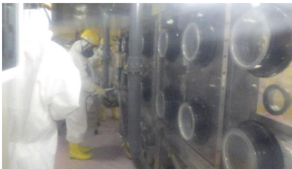
(写真5) 気密性確認の状況 (検知器をグローブボックスポート部に近づけ、漏えいの有無がないか確認している様子)
