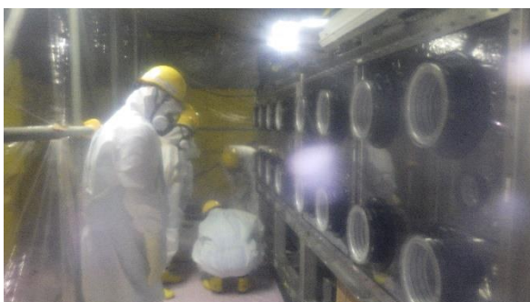
(写真2) 据付確認の状況
