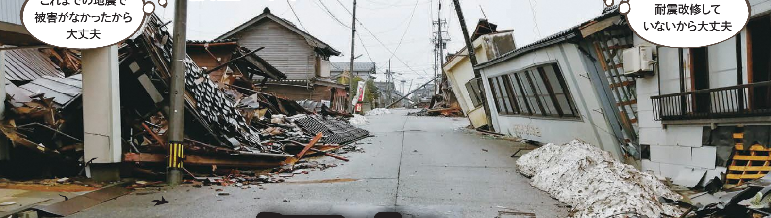
写真：[石川県能登を震源とするM7.6の地震建物被害初動調査(2024)]金沢大学・金沢工業大学
