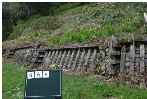
▲土留工の点検状況
