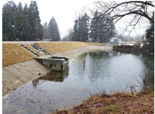
▲工事が完了した泥布沢ため池
