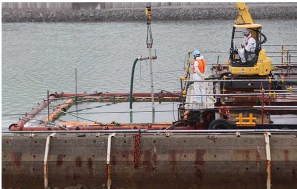
海底再被覆工事(2層目の覆土施工)の状況
