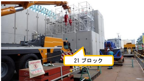
(写真2-2) ボックスカルバートの設置状況②
