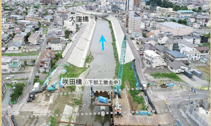
② 大窪橋から咲田橋までの区間 【令和6年7月撮影】
