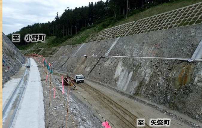
【R6施工状況（掘削が概ね完了）】
