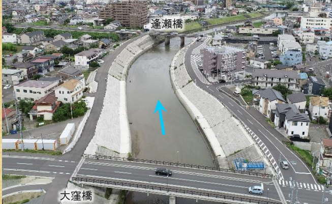
① 逢瀬橋から大窪橋までの区間 【令和6年7月撮影】
