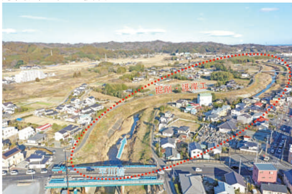
好間川1工区（平北目町地内）施工前
