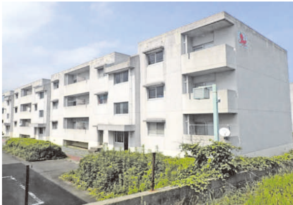
中神谷団地8号棟 外壁改修工事 (改修前)
