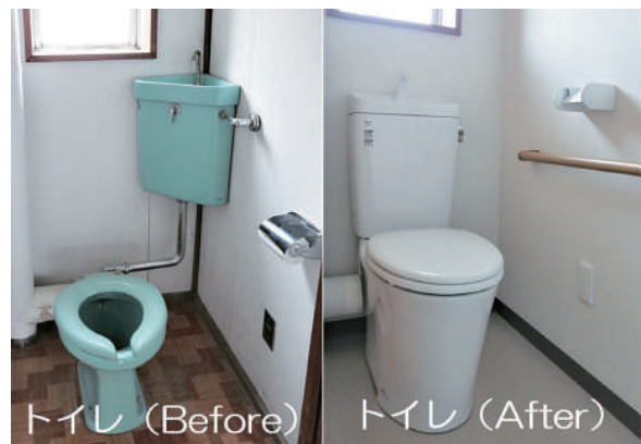
上浅貝団地 内部改善工事 (トイレ)
