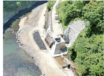
【高柴ダム】発電所法面工事竣工
