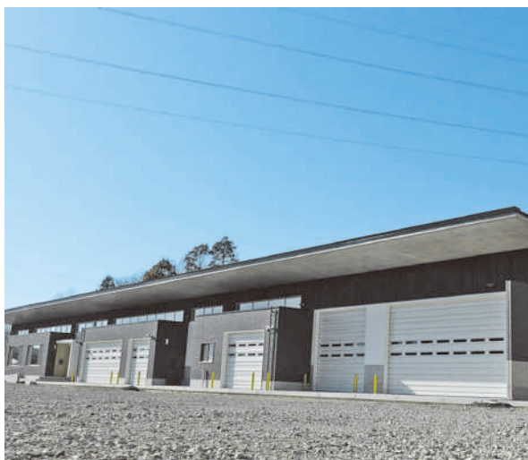
小名浜道路 管理棟新築工事（R5年度完成）
