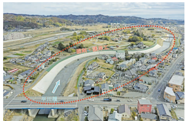
好間川1工区（平北目町地内） 令和6年3月完了
