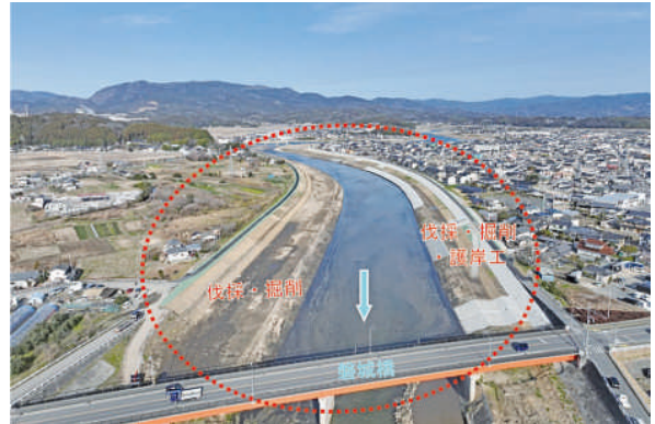
夏井川16工区（平下平窪地内） 令和6年3月完了
