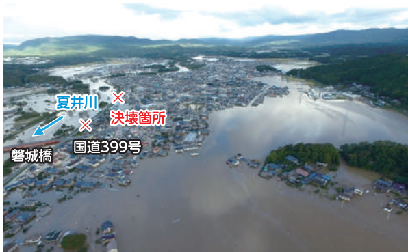
夏井川 河川堤防決壊(いわき市平下窪)
