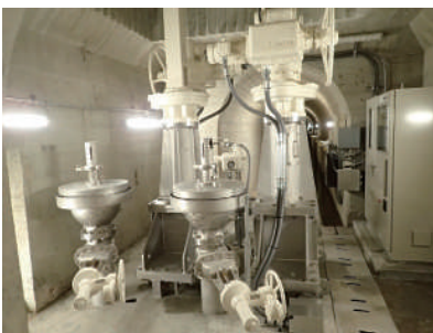
【高柴ダム】低水放流設備竣工
