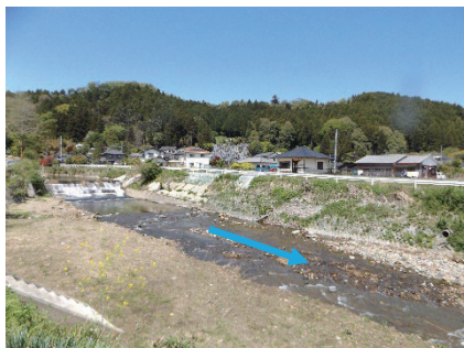
新川（内郷町広畑）被災状況
