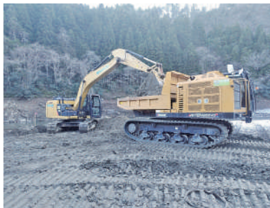
【高柴ダム】堆砂除去作業状況
