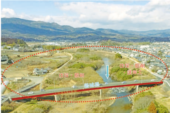
夏井川16工区（平下平窪地内）施工前
