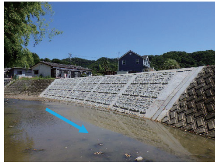
藤原川（常磐藤原町別所）復旧完了
