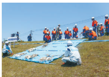
シート張り工法
