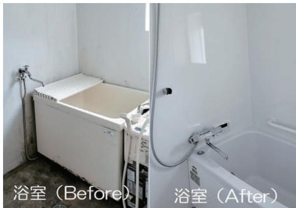
上浅貝団地 内部改善工事 (浴室)
