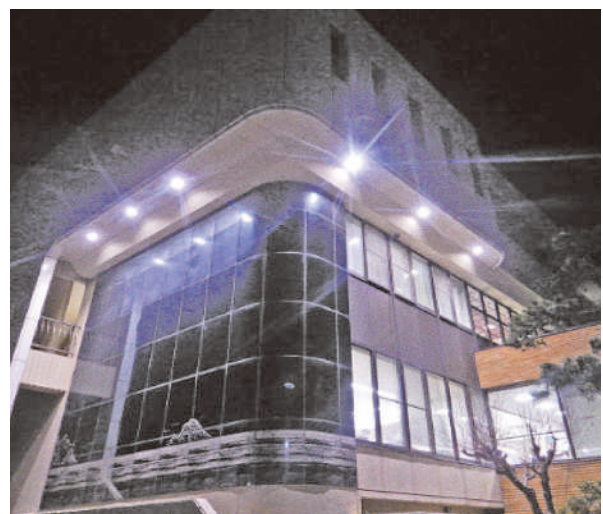
いわき東警察署 大規模改修工事（R5年度完成）
