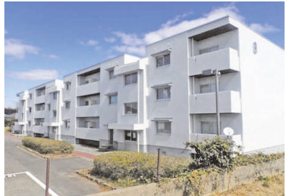
中神谷団地8号棟 外壁改修工事 (改修後)
