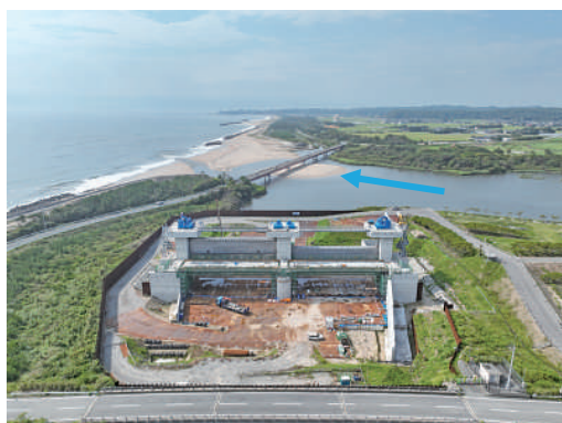
夏井川 水門工
