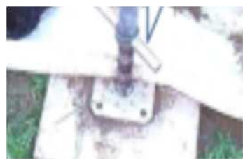
中柱（仮支柱）の根元の写真
