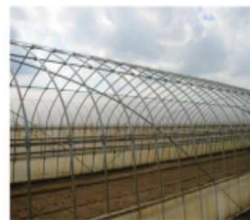
筋交いを入れた写真
