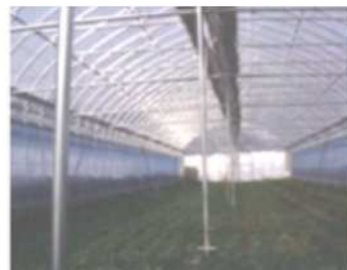
中柱（仮支柱）設置の写真
