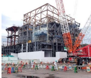
1號機大型外罩設置作業的情形
