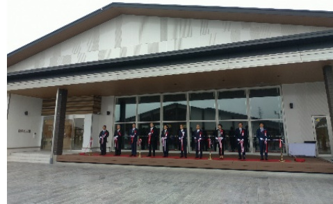
大熊町：複合設施Okumart、Hot大熊、linkru大熊
