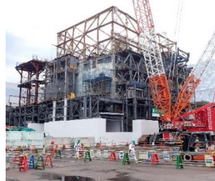
1號機大型外罩設置作業的情形
