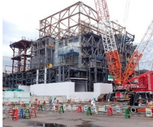
1호기의 대형 커버 설치 모습
