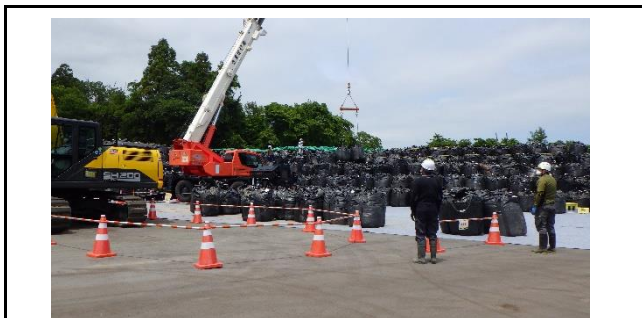
定置作業の状況 異常なし。
