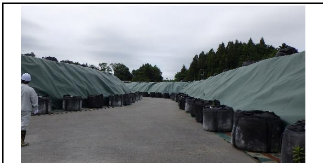
定置作業の状況 異常なし。
