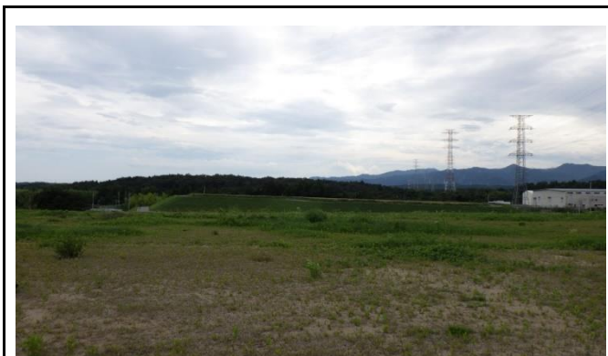
土壌貯蔵施設の状況（令和5年1月貯蔵完了） 異常なし。
