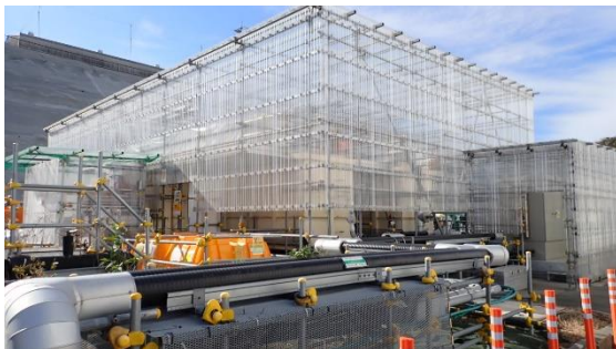
(写真1-1) 中継タンク外観 (北東側から撮影)
