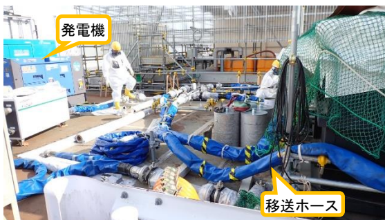
(写真1-5) 発電機及び移送ホースの設置状況
