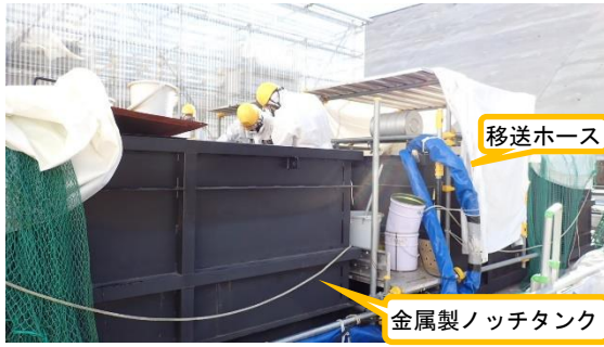
(写真1-3) 金属製ノッチタンク内水の移送作業 の実施状況
