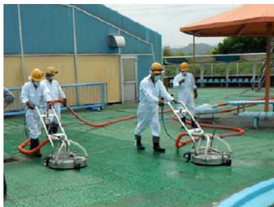
同時吸引型高圧洗浄実施
